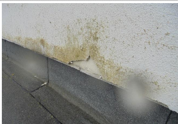
Bilde nr. 5 På enkelte av fasadene er det store skader som bør undersøkes nærmere for å kartlegge skadeårsak og omfang.
