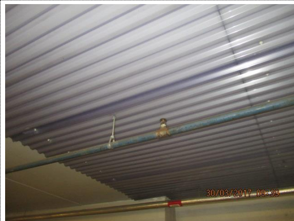
Bilde nr. 12 Rustbeskytte sprinklør og deler.
