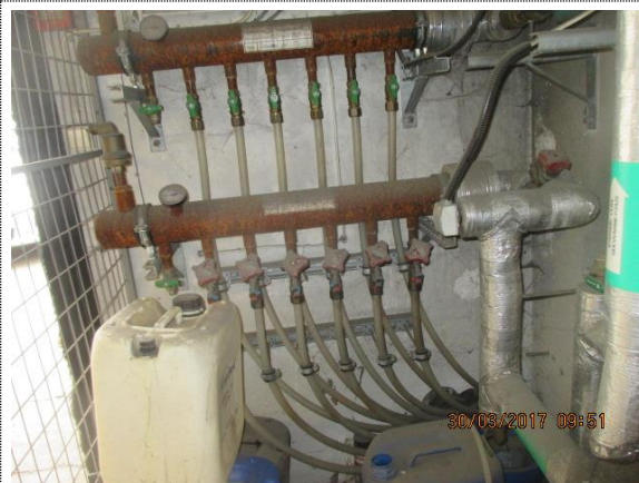
Bilde nr. 16 Rustbeskytte gatevarmerør og fjernvarmerør.
