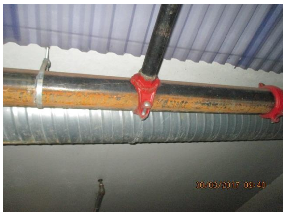
Bilde nr. 11 Rustbeskytte sprinklør og deler.
