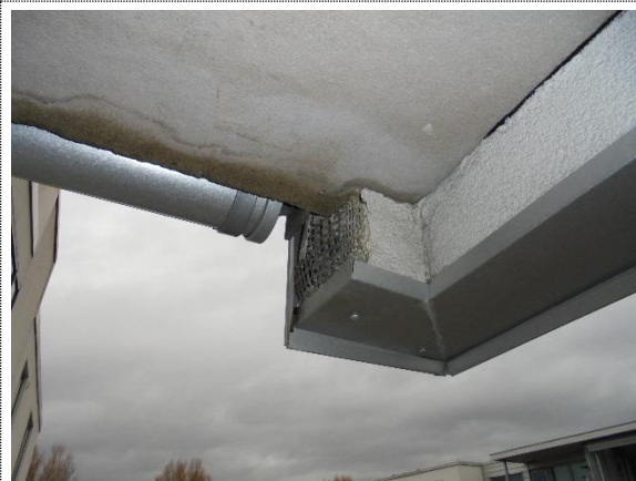
Bilde nr. 10 Merker etter en tidligere fuktskade på en av balkongene som nå er utbedret.
