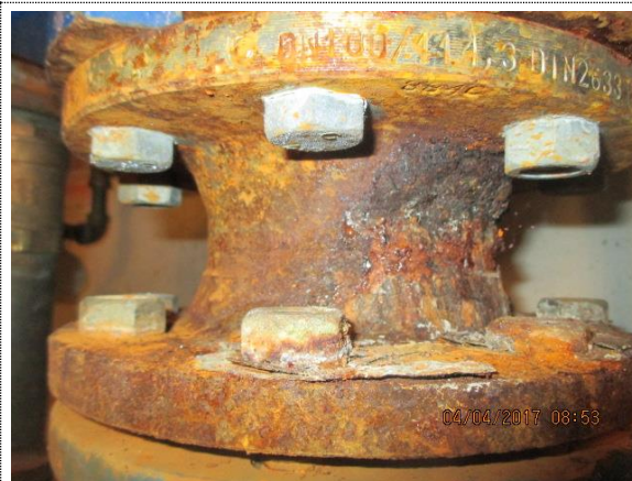
Bilde nr. 18 Rustbeskytte rør i sprinkler og varmesentral.
