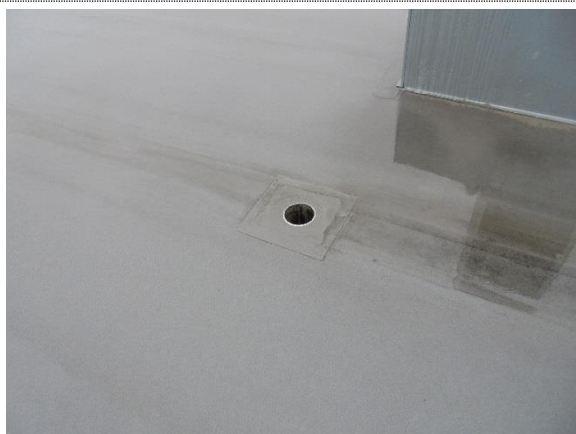
Bilde nr. 9 Det bør monteres slukrister på alle nedløpsrørene på taket.
