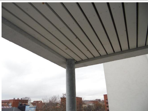
Bilde nr. 7 Spaltehimlingen over enkelte balkonger og inngangspartier bør overflatebehandles ila. de neste 10 årene.
