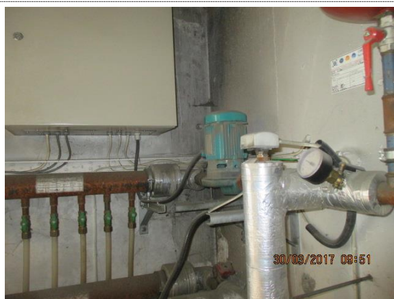
Bilde nr. 17 Rustbeskytte gatevarmerør og fjernvarmerør.
