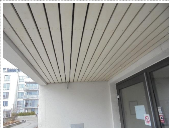
Bilde nr. 8 Spaltehimlingen over enkelte balkonger og inngangspartier bør overflatebehandles ila. de neste 10 årene.
