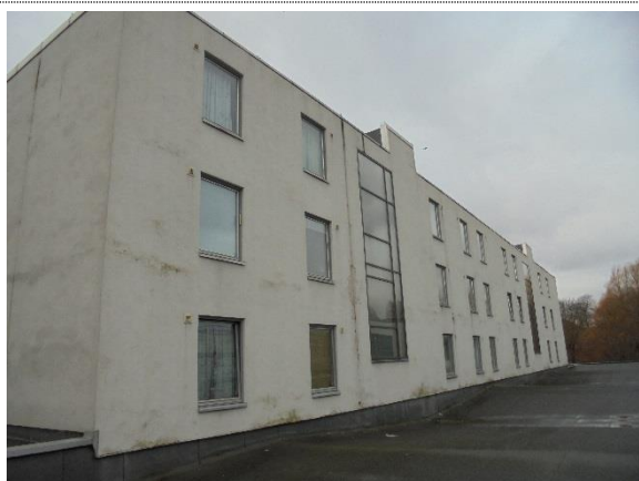
Bilde nr. 3 På enkelte av fasadene er det store skader som bør undersøkes nærmere for å kartlegge skadeårsak og omfang.
